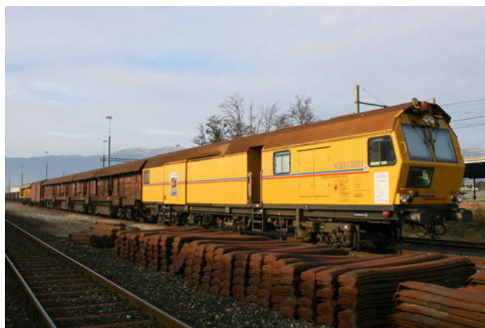
Train meuleur de rails (Scheuchzer S.A.)
